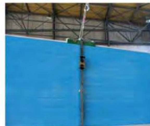
Imaginea 8. Folosirea dispozitivului de ridicat pentru panourile termoizolante cu aranjarea pe orizontală a panoului.
