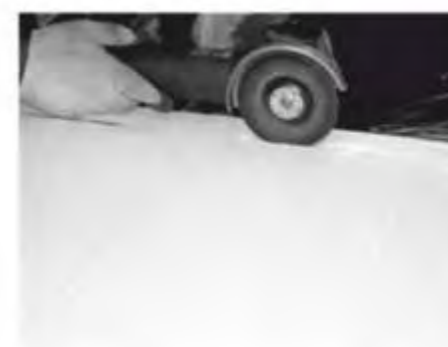
Imagine 2 Nu taiati panourile cu polizorul unghiular deoarece straturile protectoare anticorozive pot fi deteriorate.
